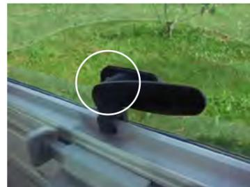
Die Fenster können auch in einer Stellung für Dauerbelüftung geöffnet bleiben, indem man den Hebel in die Aussparung der Fensterverriegelung einführt.
